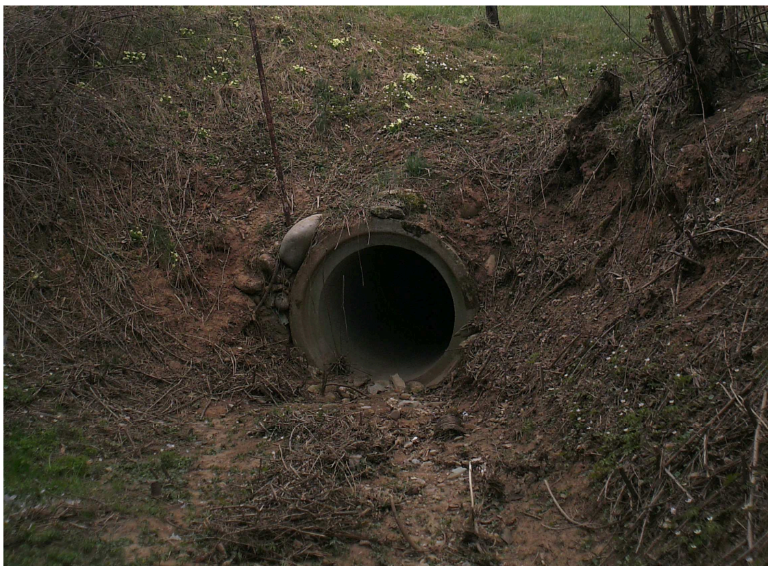
Figura 9: Tratto intubato a valle della sezione in esame
