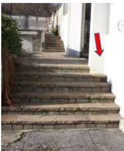
Foto 9 - 10 - Vista interna Cimitero - scale di collegamento senza corrimano
