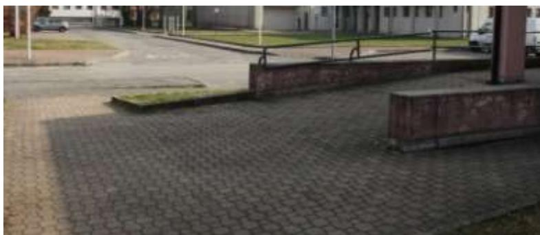
Foto 2 - Dettaglio rampa continua senza interruzione - tratto senza corrimano
