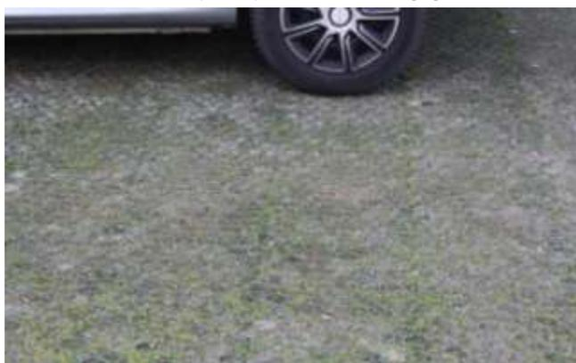
Foto 3 - Via Corte Caspani - dettaglio grigliato di pavimentazione.
