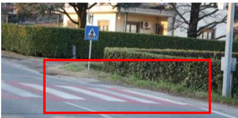
Foto 5 - De Bracchi, via Dante, scuole - attraversamento pedonale, sbarco su banchina dissestata non transitabile, largh. < 0.90 m
