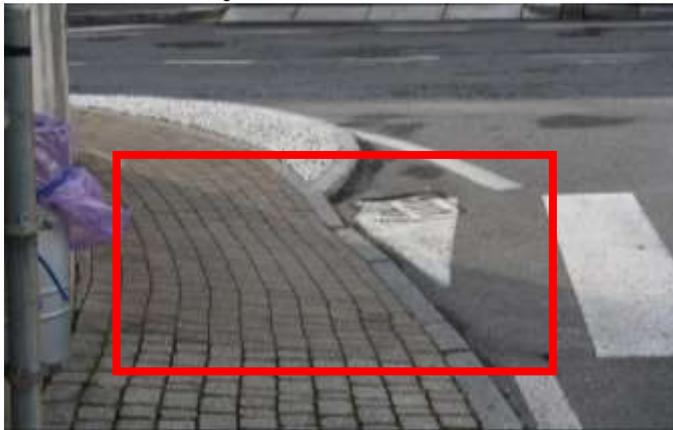
Foto 3 - Via Roma, incrocio con via E. Vismara, pedonale lato sud dislivello, pendenza trasversale > 1% - cordolatura marciapiede non parallela a attraversamento pedonale
