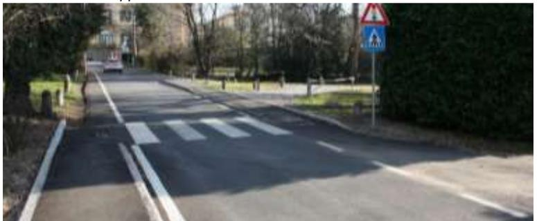
Foto 11 - Via Greppi/Chioso, banchina non segnalata con dislivello
