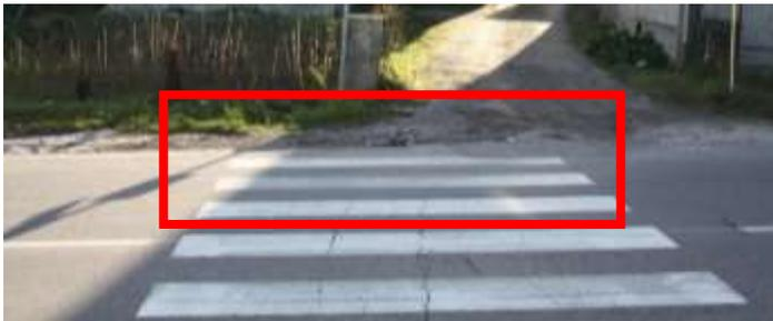
Foto 3 - Via S. Gaetano, pedonale con sbarco non pavimentato - vds foto 4
