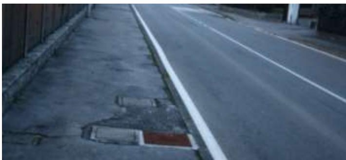
Foto 21 - Valaperta, via Petrarca, marciapiede lato ovest, banchina lato est - Pavimentazione dissestata a tratti
