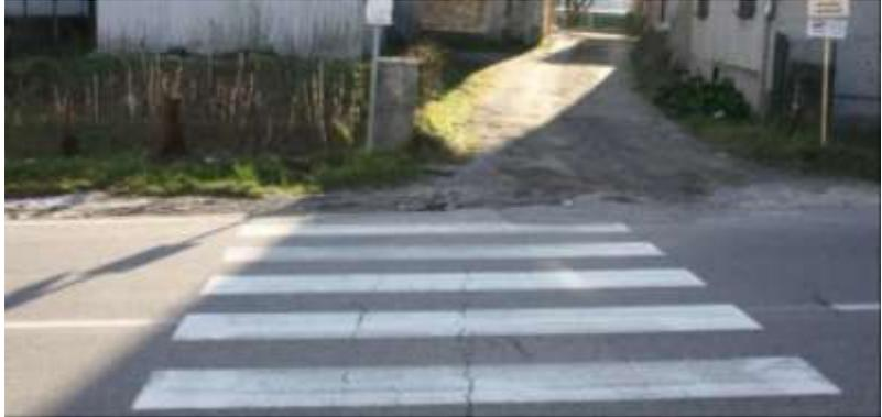
Foto 3 - Via S. Gaetano, pedonale con sbarco non pavimentato
