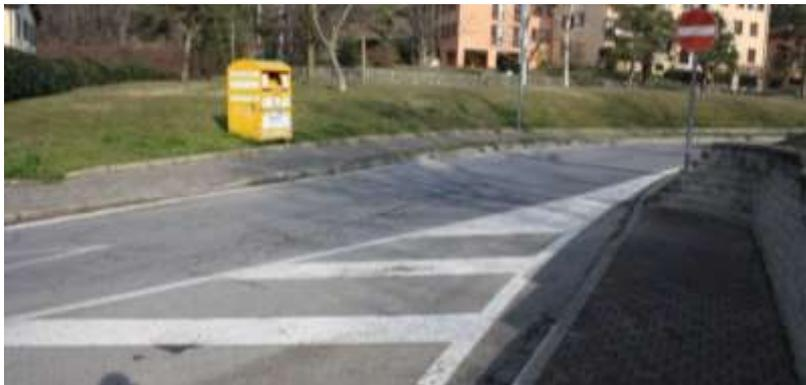
Foto 30 - via Casati - traversa nord, rotonda don Gnocchi - attraversamento pedonale non segnalato in corrispondenza scivoli
