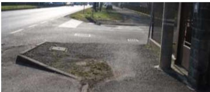
Foto 26 - Via De Gasperi/Puecher, dissesto pavimentazione, attraversamento Pedonale non segnalato
