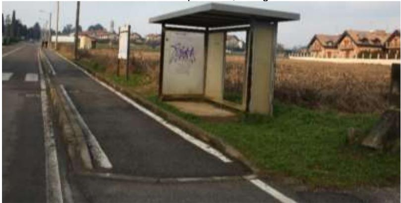
Foto 11 - Via Cavour est - Fermata TPL con ostacolo, dislivello e banchina non pavimentata
