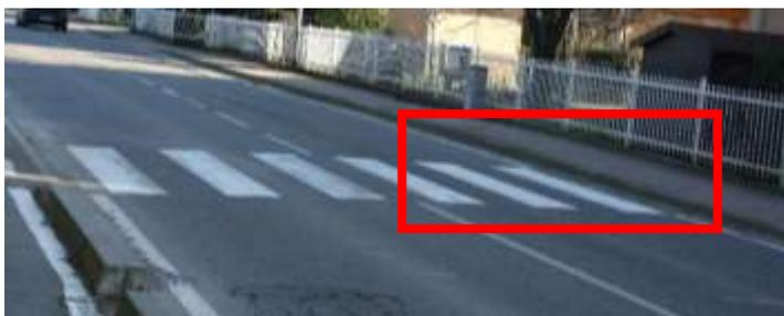
Foto 15 - Rogoredo - via Volta, attraversamento pedonale con dislivello lato sud
