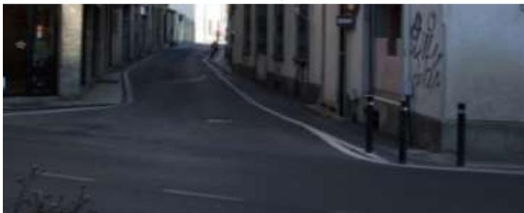
Foto 13.1 - Via Cavour/Verdi, percorso pedonale/banchina larghezza < 90 cm, pavimentazione sconnessa; attraversamento pedonale via Verdi non segnalato
