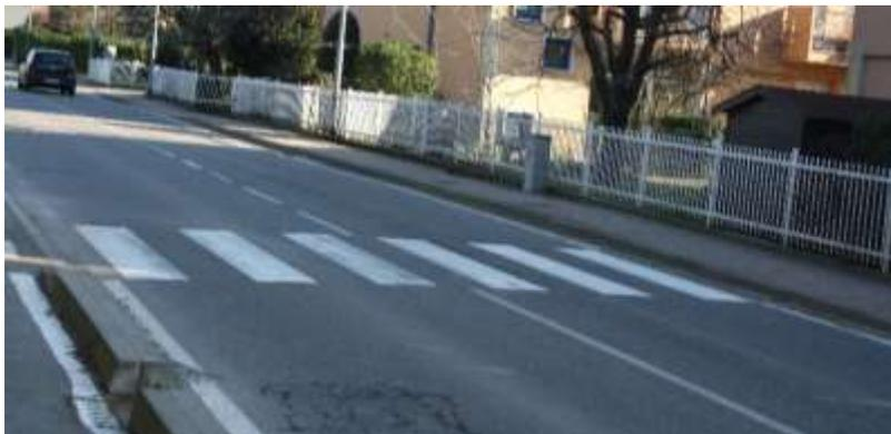
Foto 17 - Rogoredo - via Volta, attraversamento pedonale con dislivello lato sud
