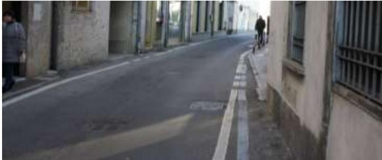
*Foto 10 - Via Verdi - banchina < 0,90 m - pavimentazione dissestata*
