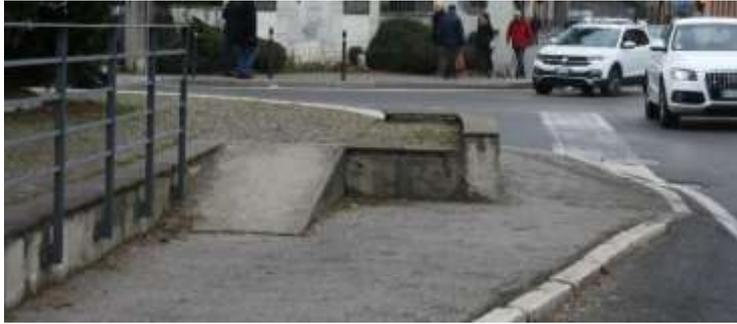
Foto 11 - Via Cavour, rampa di raccordo dislivello marciapiedi non protetta
