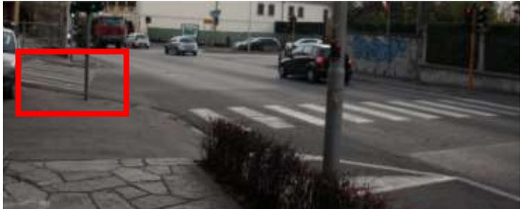
Foto 3 - Via Roma, incrocio con via E. Vismara, pedonale sud con dislivello e con segnalazione discontinua.
