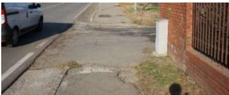
Foto 20 - Via De Gasperi est pavimentazione dissestata - Attraversamento pedonale non segnalato
