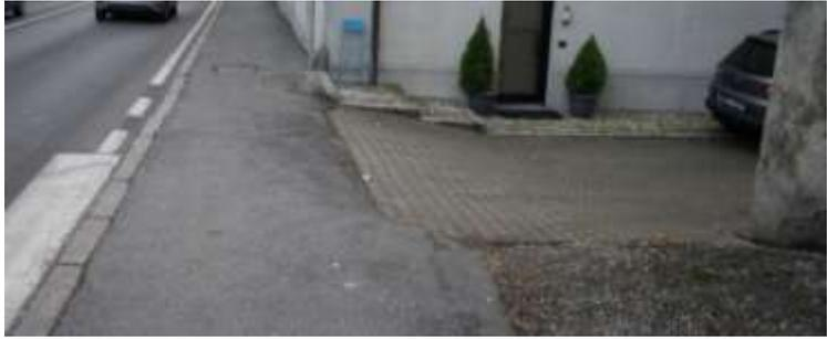
Foto 2 - Via Roma ovest, pendenza rampa > 8% collegamento a via del Lavoro
