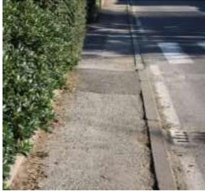
Foto 1.2 - Rimoldo - via Volta (dettaglio foto 1.1) - pavimentazione dissestata
