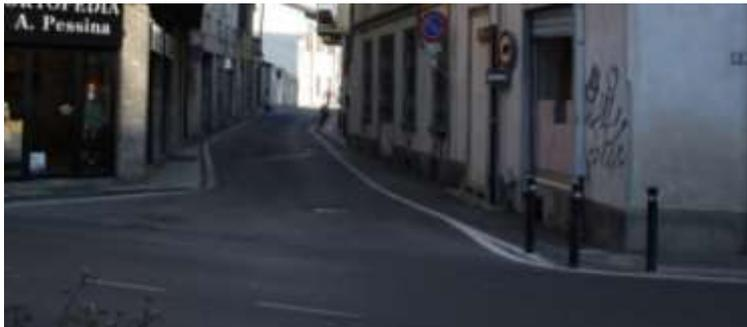
*Foto 9 - Via Verdi - marciapiede e banchina < 0,90 m - pav.ne dissestata*
