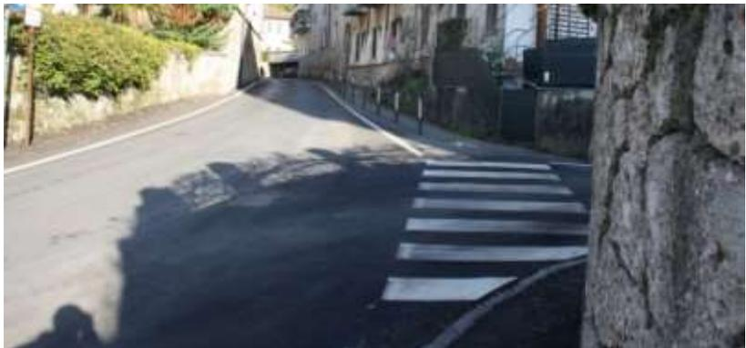
Foto 13 - Via Castelbarco/Circonvallazione, banchina lato nord < 0,90 m; attraversamento pedonale non ortogonale
