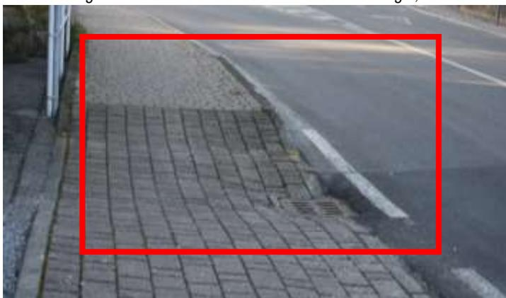
Foto 1.1 - Galgiana - via Buttafava - marciapiede lato sud pavimentazione pavimentazione dissestata, pendenza trasversale > 1%
