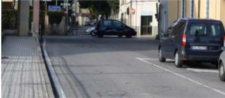
Foto 23 - Via Misericordia, banchina lato nord < 0,90 m
