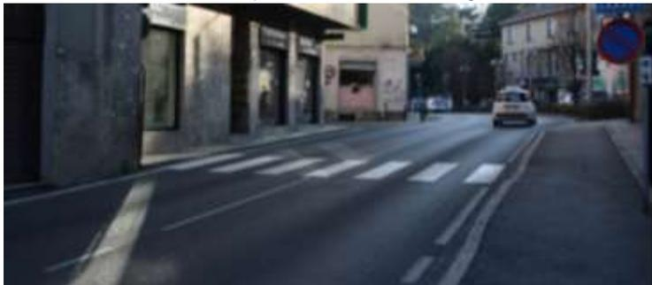
Foto 13 - Via Cavour/P.zza Mazzini/Via Verdi, attraversamento pedonale - dislivello > 2,5 cm - manca scivolo di raccordo
