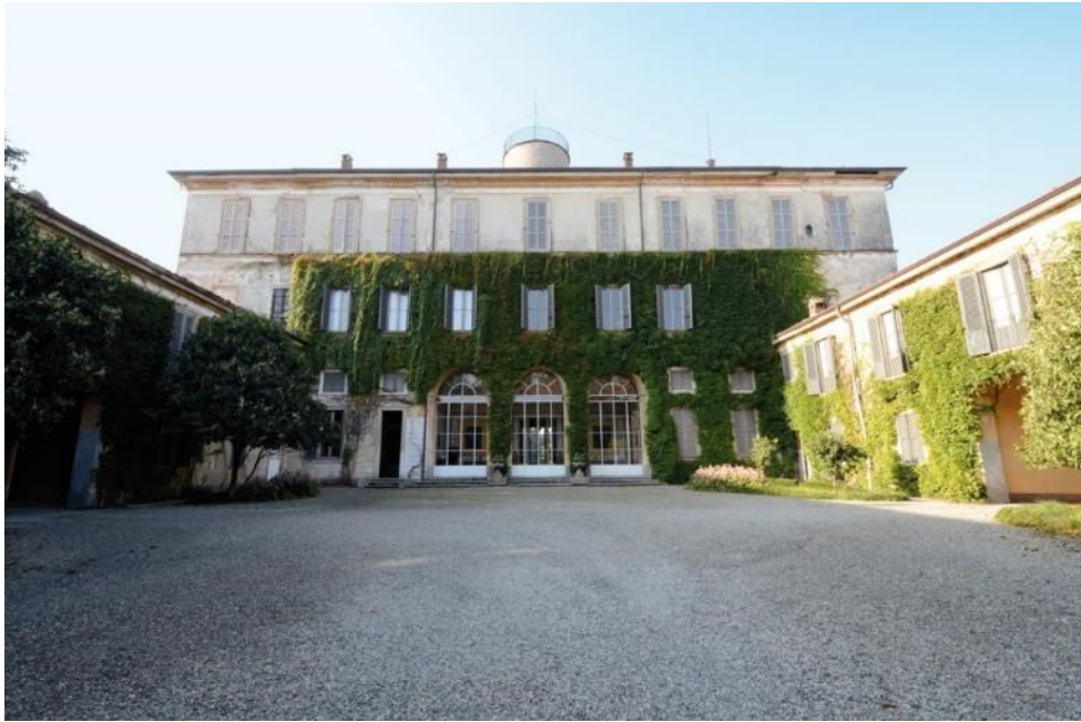
Fig. 10 - Vista di Villa Greppi Bussero
