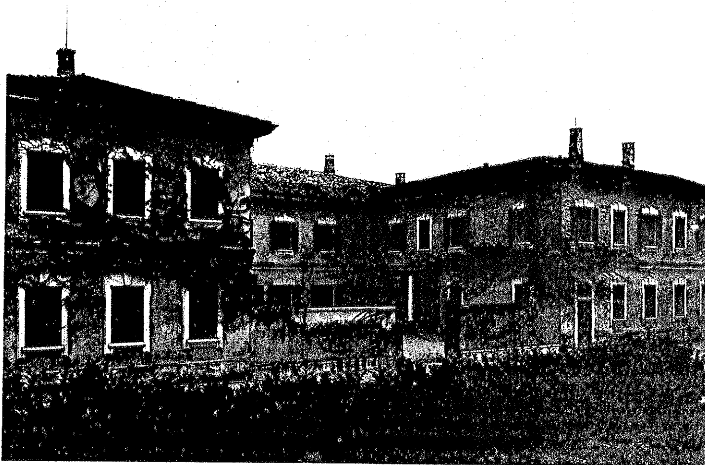
Facciata nord-ovest sulla strada, con la corte d'ingresso
