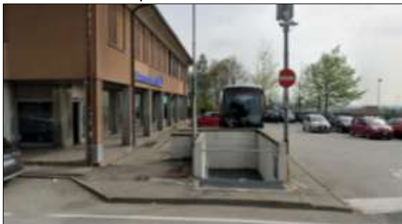
- Dislivello per accesso a sottopasso pedonale
